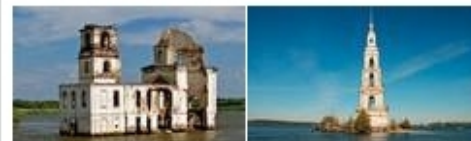
Печальные плоды стройки века
